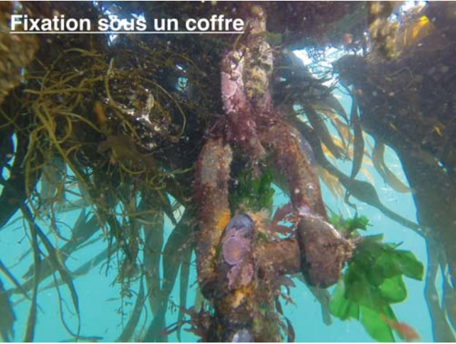
Chaine fille sous coffre d'amarrage 36mm - pas 66mm
