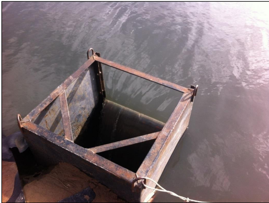
▲ Exemple de dispositif d'écluse à réglage par batardeau en bois.
