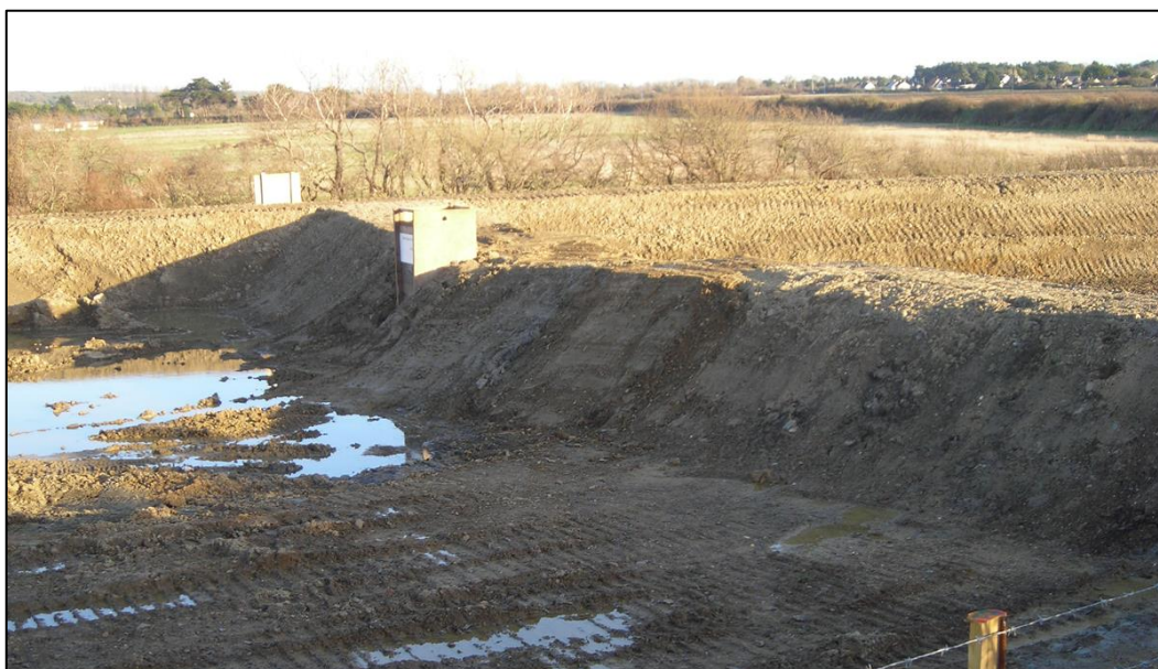
▲ Aménagement de bassins de décantation et d'écluse (Barneville, 2008)
