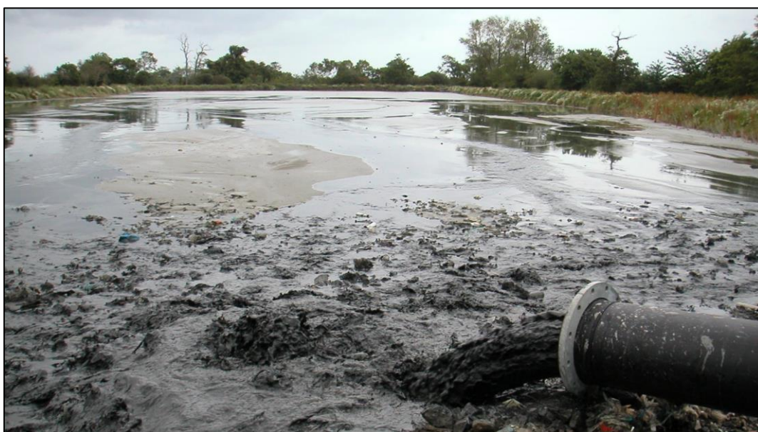
▲ Lagunes de déshydratation des sédiments - Dragage de Saint-Vaast (Source : MARC SA, 2002)
