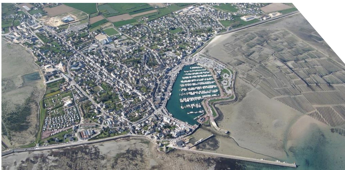
Dragage du Port de Saint-Vaast la Hougue
