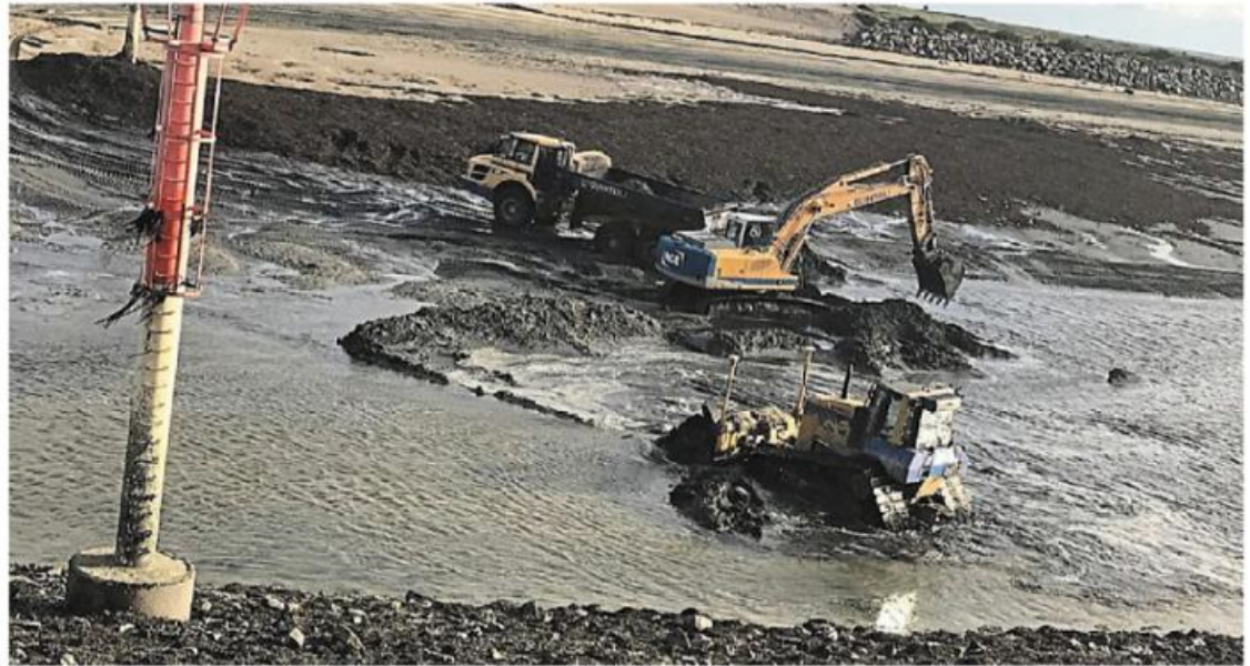
Les travaux dans le chenal du port de Barneville-Carteret ce jeudi 17 octobre 2019
