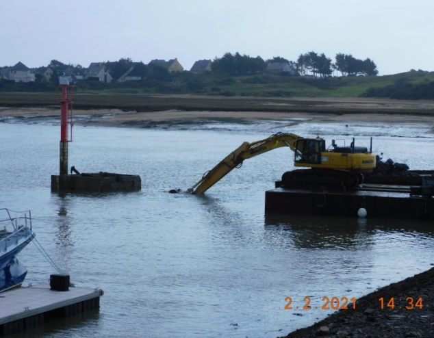
Démontage ancienne porte
