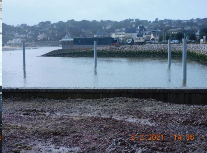
Les premiers poteaux
