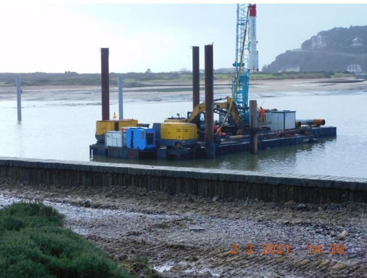
Barge pour mise en place des poteaux
