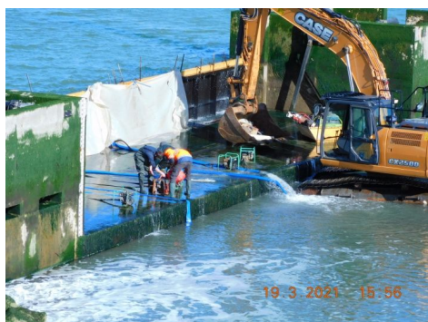
Travaux sur la porte
