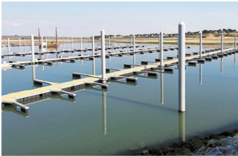
L'installation de ces nouveaux pontons donne une autre dimension au port. Elle double la capacité d'accueil du bassin à flot (autour de 700 places), sans augmenter l'emprise portuaire, grâce à la mise en eau d'une partie du chenal. Une idée de la précédente municipalité, portée par le Département dans le cadre de son Plan nautisme « pour valoriser ses atouts maritimes ».
