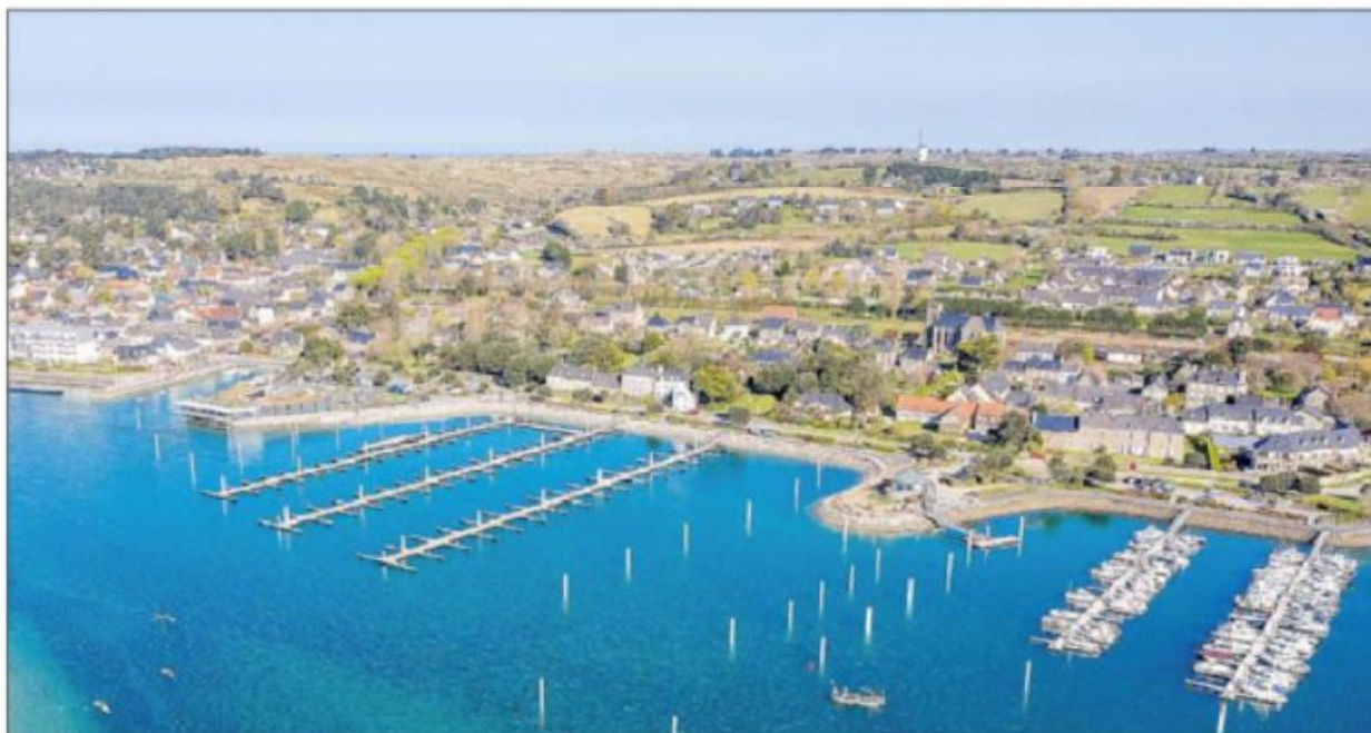
Sur cette vue aérienne fournie par la SPL, on découvre le bel avancement des travaux et l'impact de la nouvelle infrastructure sur le village de Carteret.
