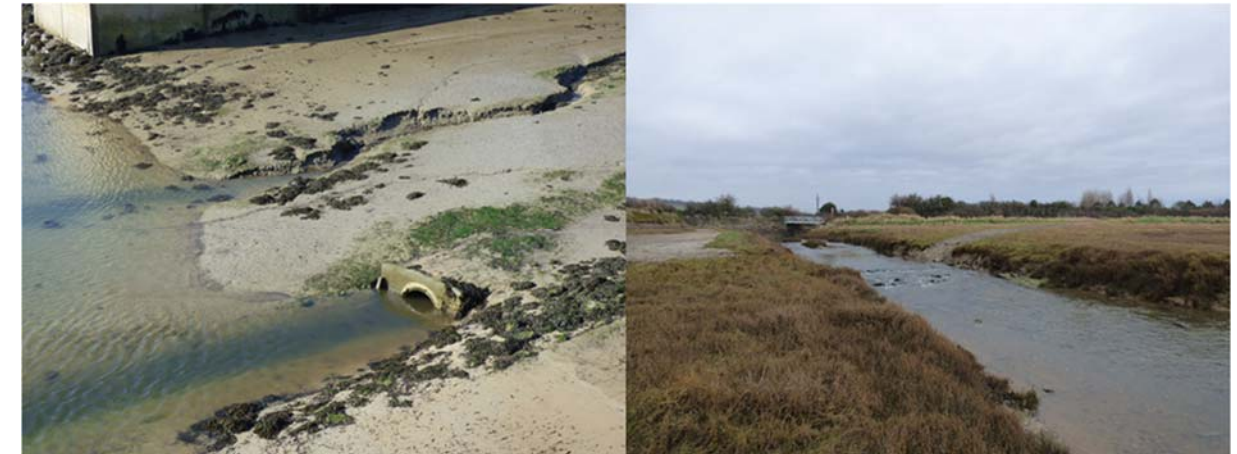
Figure 50 : A gauche, l'exutoire du ruisseau des Douits au niveau du port des Américains ; à droite, la Gerfleur au niveau du havre (Photos IDRA, 2017)
