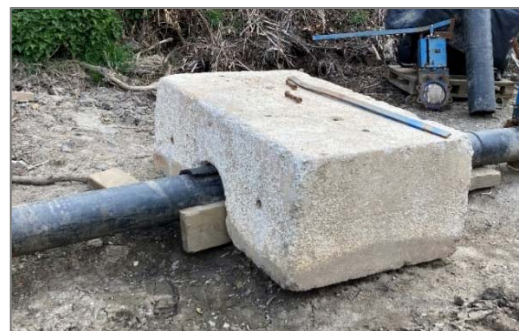
Figure 12 : Exemple de cavalier béton servant au lestage de canalisation
