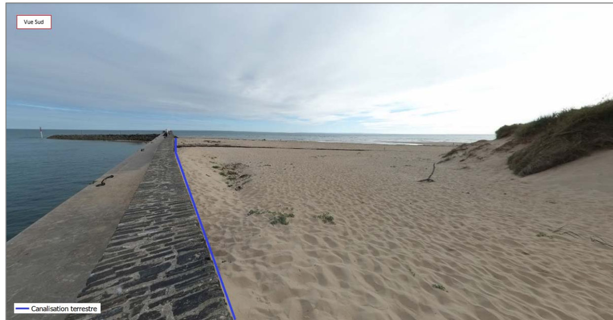
Figure 78 : Vue Sud du passage de la canalisation de refoulement (IDRA, 2022)
