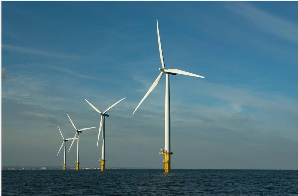
Les éoliennes seront posées sur une fondation monopieu avec une pièce de transition en jaune émergeant de la surface. | PHOTO EDF RENOUVELABLE
