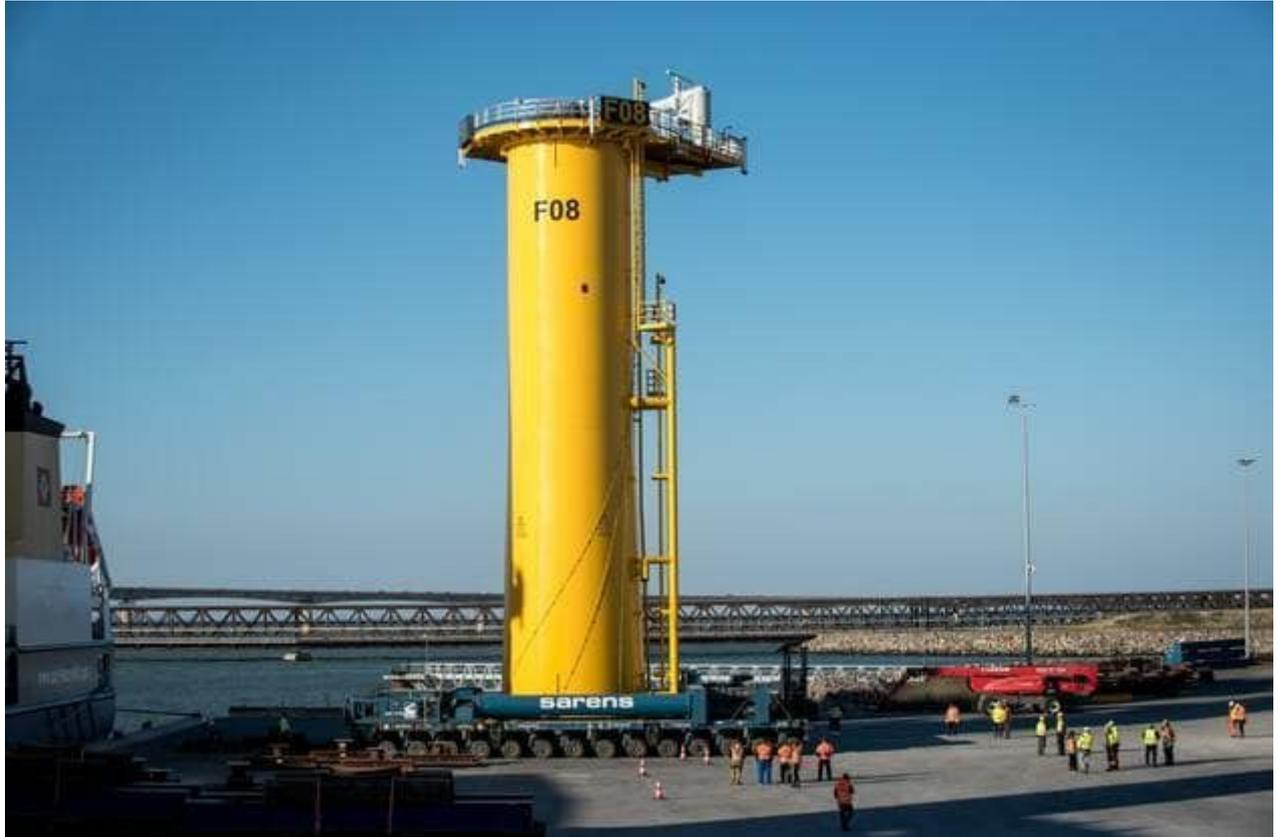
La pièce de transition jaune sur laquelle sera installé le mât de l'éolienne. | PHOTO PARC ÉOLIEN EN MER DE SAINT-NAZAIRE | PRODUCTION CAPA CORPORATE
