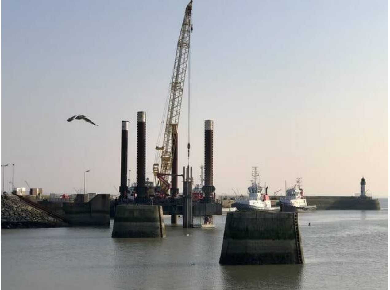
Les travaux sont bien visibles dans la pince de crabe. | PHOTO PO-ND
