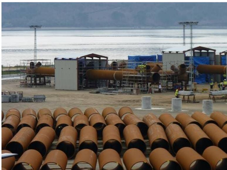
Les jambes, des éléments pour construire une fondation d'éolienne en mer (aussi appelée « jacket »). | OUEST-FRANCE
