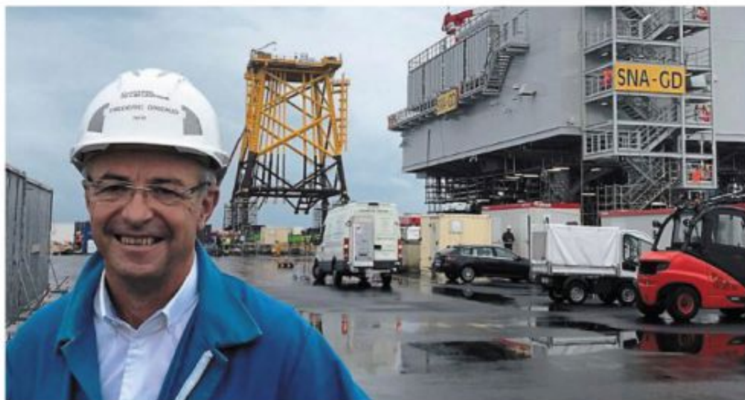
Frédéric Grizaud (Chantiers de l'Atlantique) devant les éléments de l'énorme sous-station électrique de Saint-Nazaire.
