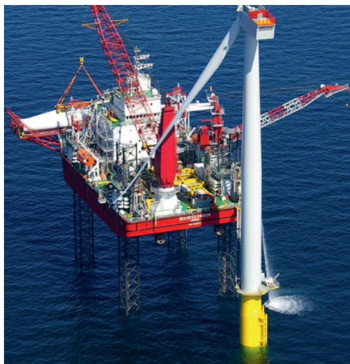
Navire doté de moyens de levage pour l'installation d'éoliennes en mer
