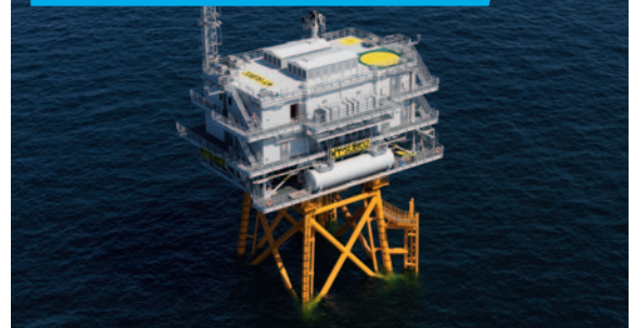
Poste électrique en mer du parc éolien DONG Energy de Walney
