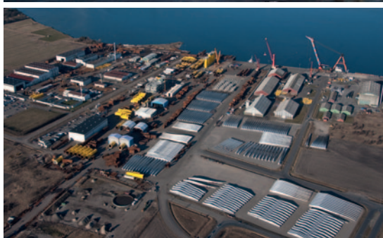
Assemblage et stockage des éoliennes
