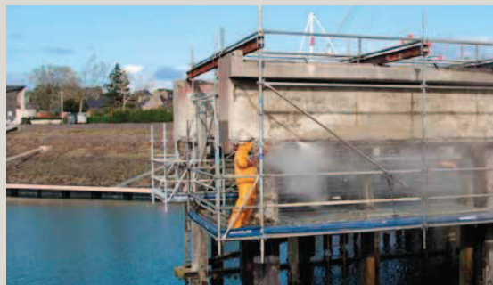
Utilisée pour la première fois dans la Manche, la technique d'hydro-démolition a été privilégiée pour décapier le béton et mettre à nu le ferrailage.
