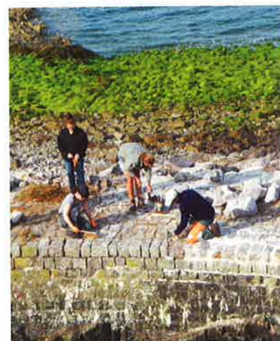
Réfection des joints de la digue.
