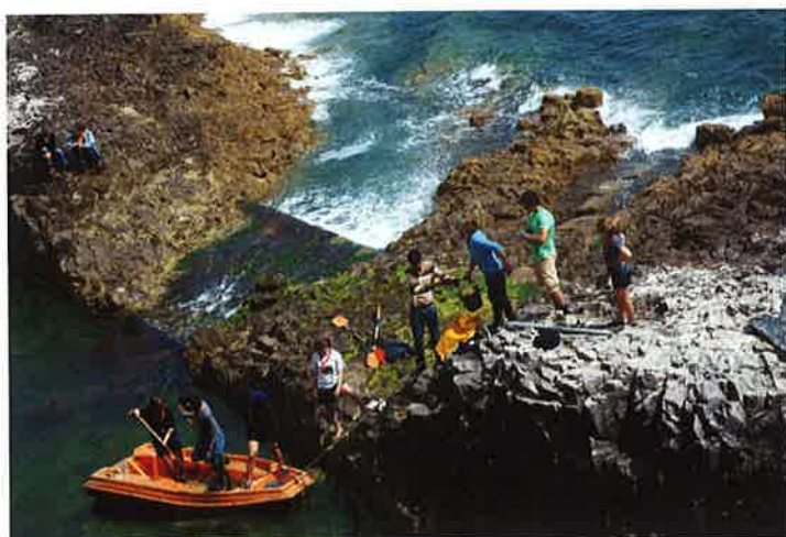
Acheminement du sable pour la maçonnerie.
