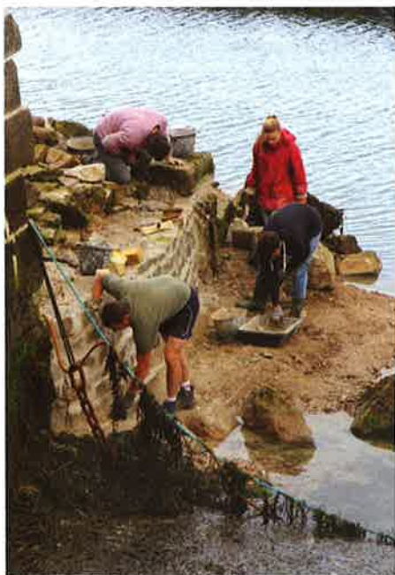
Réfection du mur sur le môle.
