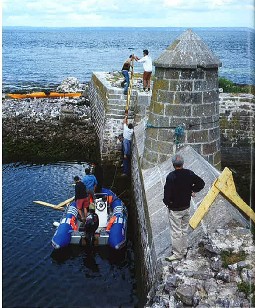
Installation d'une passerelle d'accès au chantier.
