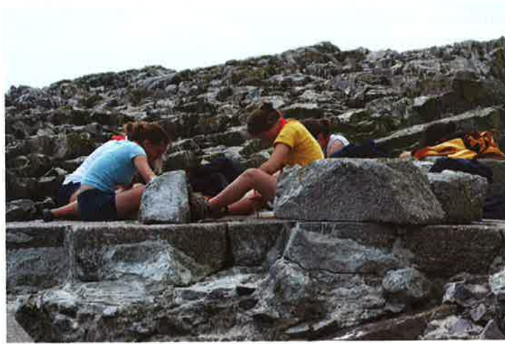
Les filles se font maçonnes.
