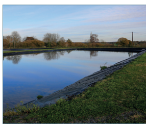
> Station de lagunage à Saint-Sansom-de-Bonfossé
