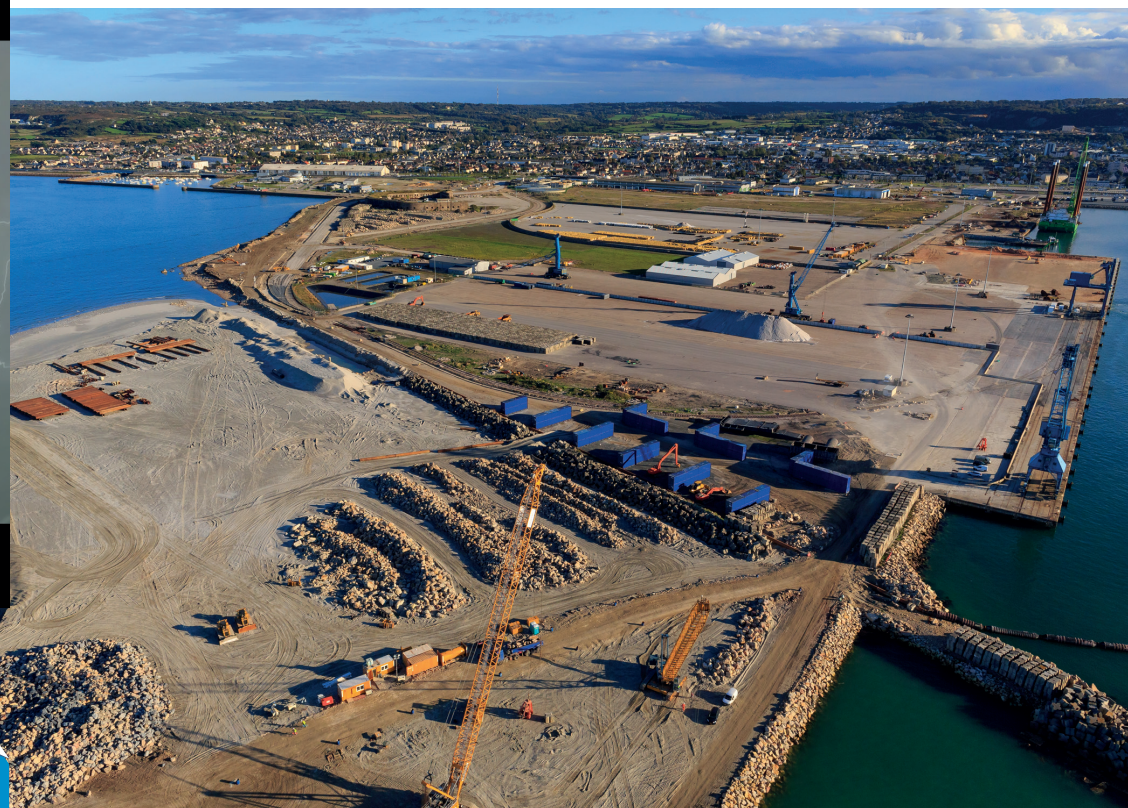
› Travaux d'extension du port de Cherbourg © Jérôme Houyvet/lumieresmarines.com
